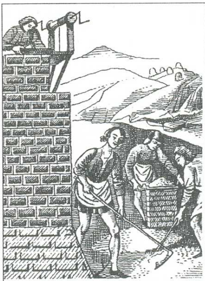
Праця каменярів на будівництві. З середньовічної мініатюри
